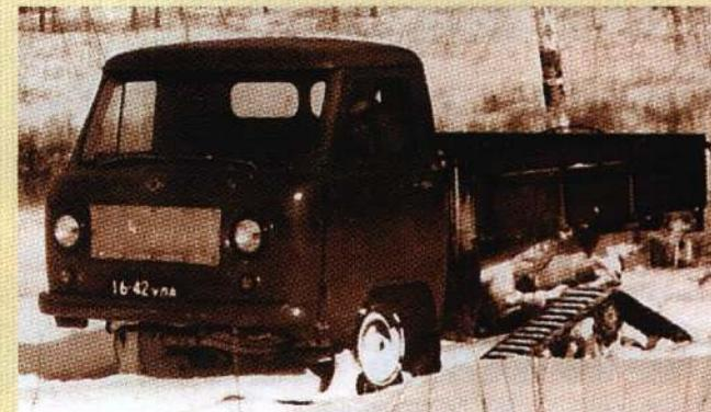
В 1972 году была предпринята попытка повысить проходимость грузовика «УАЗ-455» установкой полугусеничного движителя, однако все окончилось несколькими опытными образцами. Фото с разрешения В.Л. Несоленого
