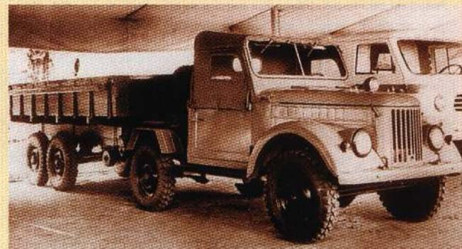
На первых порах в Ульяновске решили построить несколько образцов модификаций «ГАЗ-69», и первым из них стал седельный тягач «УАЗ 456» с двухосным прицепом-платформой «УАЗ-750». Фото из архива А.С. Исаева
